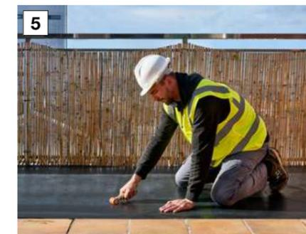
5 Presionar toda la superficie con el rodillo del sistema.
