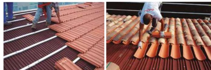
Composición en masa + Doble resina y Solape de Seguridad
